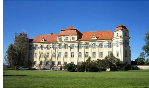
Schloss Tett nang mit neuem Verputz
